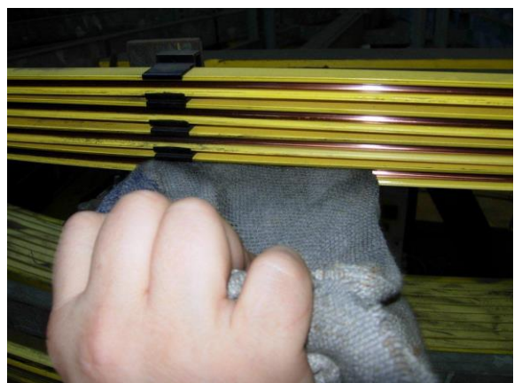
Afbeelding 9: Ook vuil dat op de railhouders aanwezig is, verwijderen
