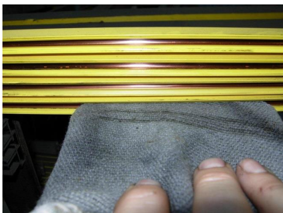
Afbeelding 8: Alle polen achter elkaar reinigen
