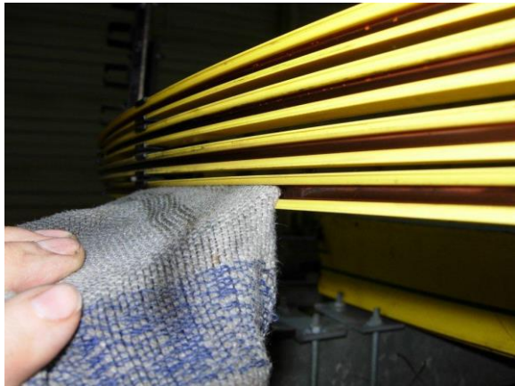
Afbeelding 10: Contacthoek van het reinigingsgereedschap wijzigen om verschillende zones te reinigen
